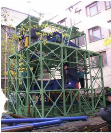
Рис.4. Сборка мини-фабрики производительностью 10 – 12 т/час
